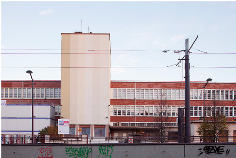
Le CHU La Boulangerie est installé dans une ancienne caserne. © Daniel Moulinet
