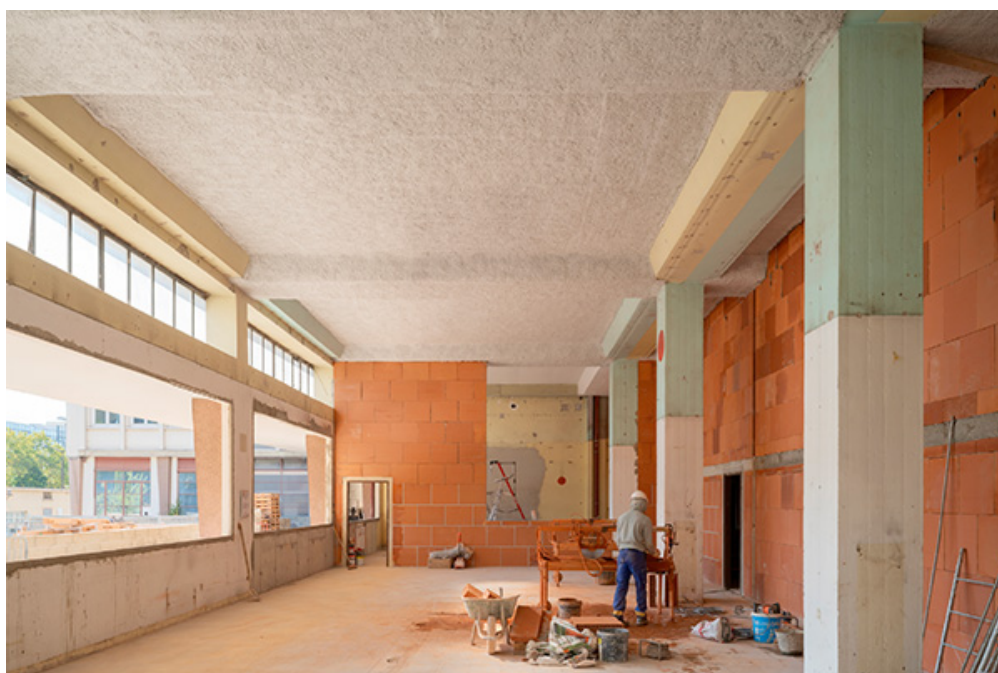
Le chantier a duré un an. © Jared Chulski
